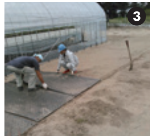
ボードを敷設する
