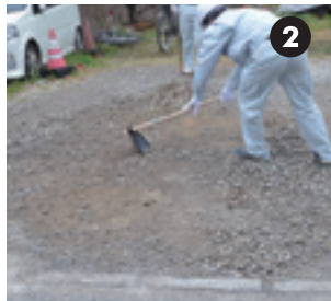
地面が平らになるよう敷き均す
